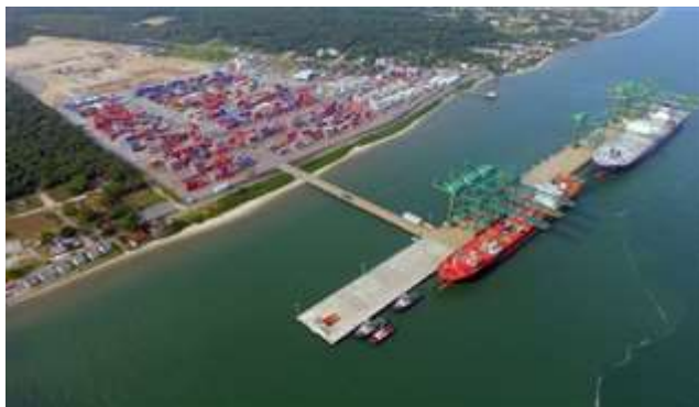
Source: Itapoá Private Container Terminal, portoitaipoa.com.br, 2020.
